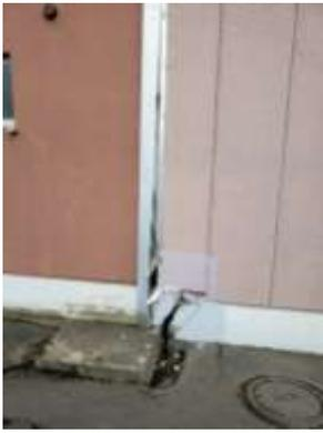
地震直後の事務所増築部分の基礎に亀裂が入り、隙間ができる。
